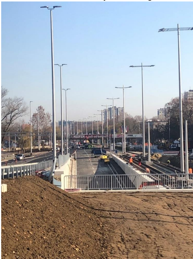
Slika 7 - Velika ulaganja na komunalnoj infrastrukturi (rekonstrukcija Rotor)
